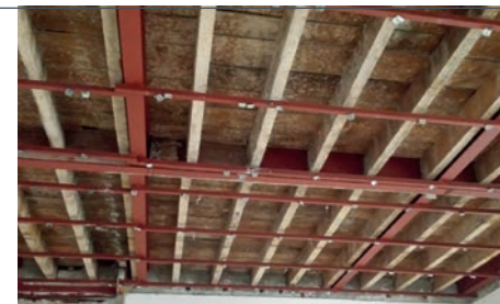
Opere di rinforzo metallico dei solai lignei. ©F&M Ingegneria
