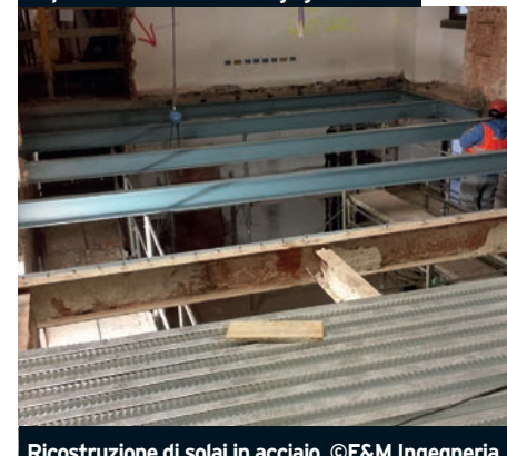
Ricostruzione di solai in acciaio. ©F&M Ingegneria
