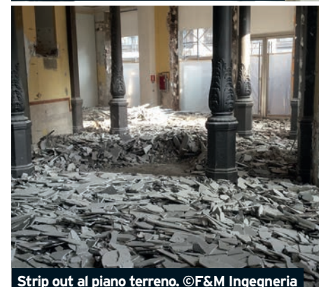
Strip out al piano terreno. ©F&M Ingegneria
