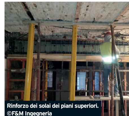
Operazioni di rinforzo del solaio del piano terra. ©F&M Ingegneria
