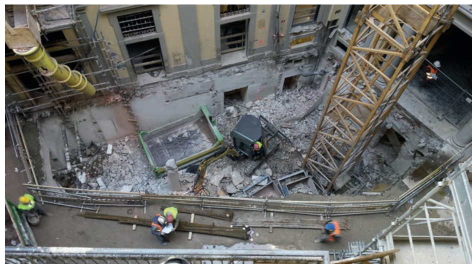
Demolizione della porzione di solaio del piano terra precedentemente utilizzato a cortile, che ha consentito di realizzare il nuovo gruppo scale. ©F&M Ingegneria
