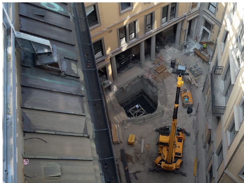
Cortile interno, una delle prime operazioni è stata quella di demolire il solaio per l'inserimento del basamento della gru e della scala di collegamento al piano interrato e piano primo. ©F&M Ingegneria
