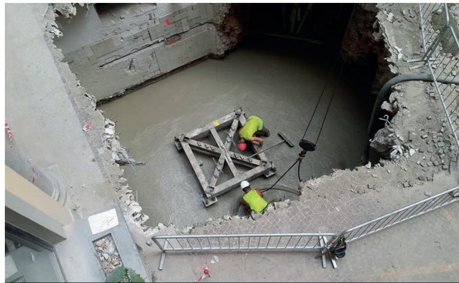
Posizionamento del basamento della gru per la realizzazione del piano interrato. ©F&M Ingegneria
