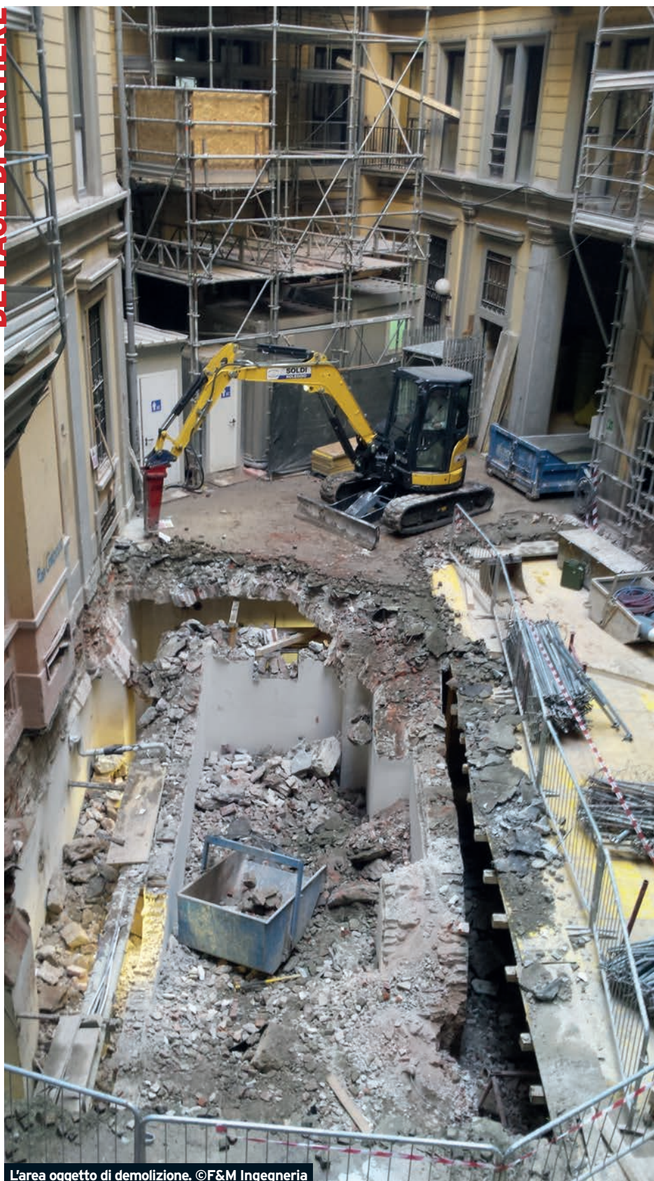
L'area oggetto di demolizione. ©F&M Ingegneria
