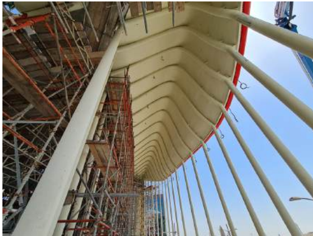
Gli archi a raggio variabile che sorreggono la copertura con scafi rovesciati / The variable-radius arches supporting the roof with inverted shells
