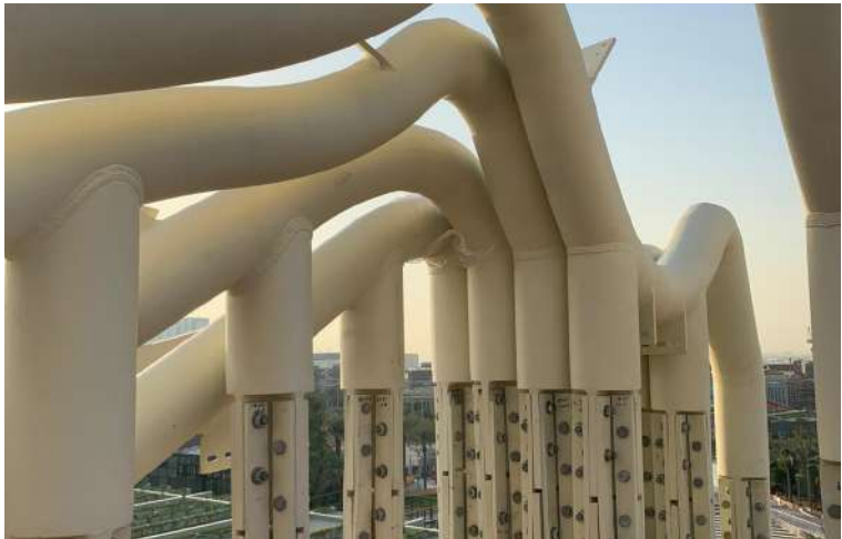
Gli archi a raggio variabile che sorreggono la copertura con scafi rovesciati / The variable-radius arches supporting the roof with inverted shells
